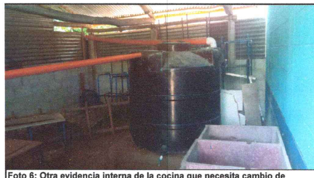
Foto 6: Otra evidencia interna de la cocina que necesita cambio de entechado y complemento de pared de concreto.
