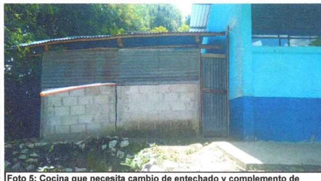
Foto 5: Cocina que necesita cambio de entechado y complemento de pared de concreto.
